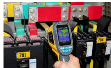
Manutenzione della linea del trasformatore Transformer line maintenance
