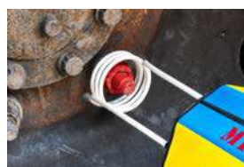
Smontaggio bulloni Disassembling bolts
